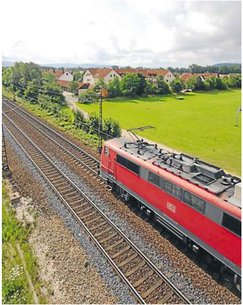
Auf dem Weg rechts neben der Lok soll der Lärmschutzwall auf städtischem Grund und auf Kosten der Stadt entstehen.
