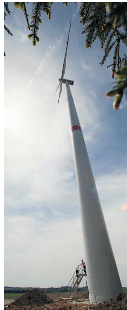
In über 100 Metern Höhe in der Gondel findet sich ein Maschinenraum - dem blauen Generator steht ein Rechenschrank gegenüber (links). Die Dimension der Windkraftanlage mit 125 Meter Narbenhöhe und einem Rotor mit 90 Metern Durchmesser lässt sich am besten mit Abstand erkennen (rechts). Fotos: Distler
