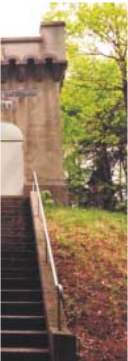
des Bauwerk: Nähe des Brunnenhäusls.
